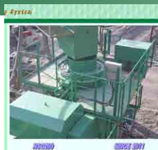
カメラで運転状況確認
