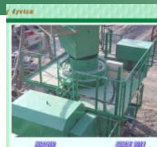
カメラで運転状況確認
