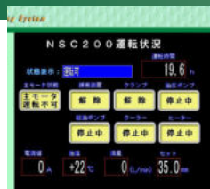
タッチパネルで運転確認
