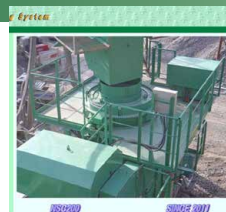
カメラで運転状況確認
